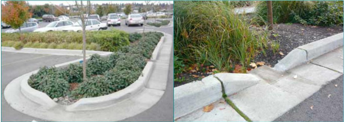
Kuva 1. Esimerkki pysäköintialueen huleveden imeytyspainanteesta (lähde: Hulevesiopas, kuntaliitto, 2012)
